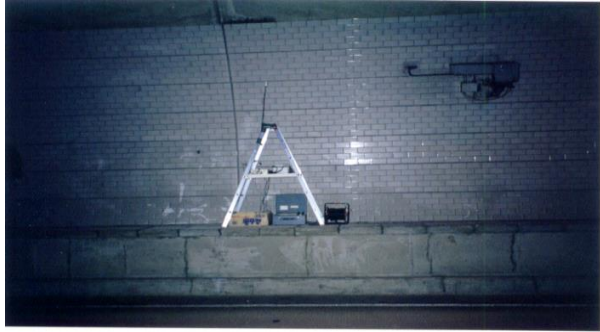
· 터널 내부 측정 (온습도 / 풍속 / 오염농도 등)
