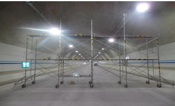
· 터널 TAB 측정
